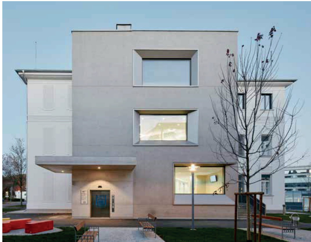
Balloon Architekten: Um- und Zubau der Ambulanz, der Hämatologie und der Büros im LKH Graz
